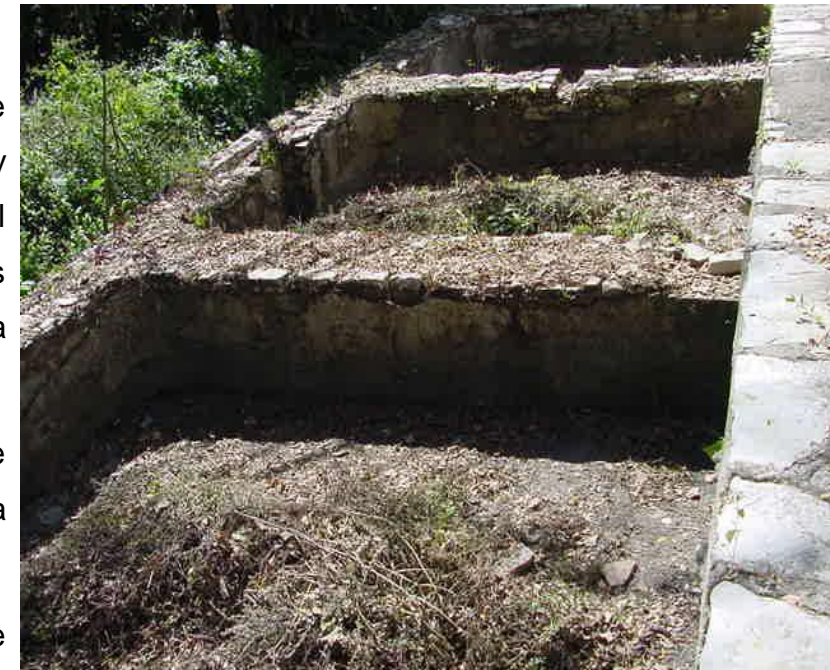
Fig. 19 Fotografía tomada en trabajo de campo. Tanques de fermentación
