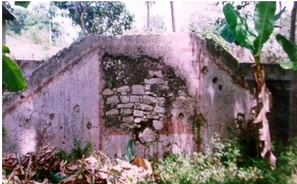
Fig. 20 Fotografía tomada en trabajo de campo. Centru de las terrazas-secaderos
